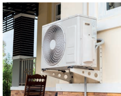
La pompe à chaleur air/air ▼
